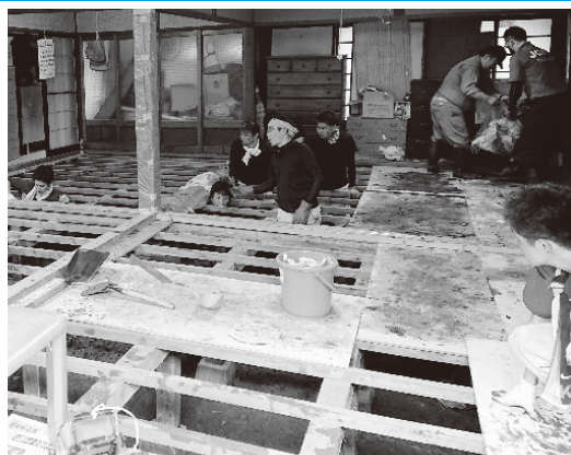
R5白岩川水害 床下泥出し作業の様子
